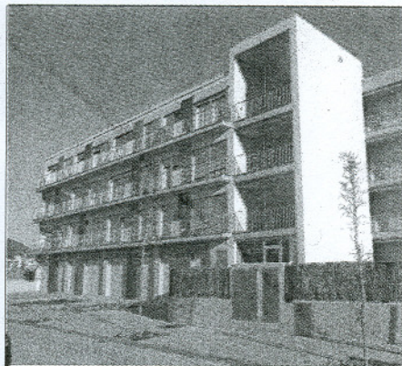
Un dels edificis de la promoció, a la Plana Est
